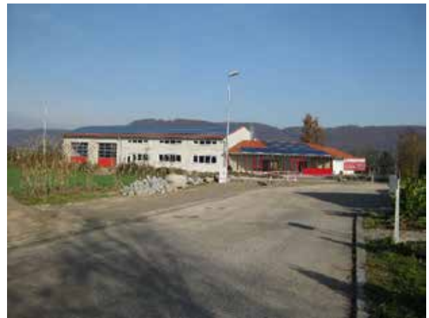
Firma Schwab: Lüftung Heizung Sanitär
